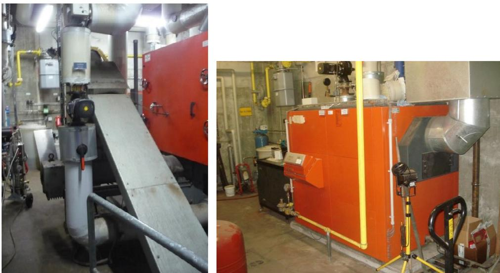
**Abb. 48:** Holzkesel 300 kW, Bj. 2002 (links), Gaskessel 575 kW, Bj. 2002
