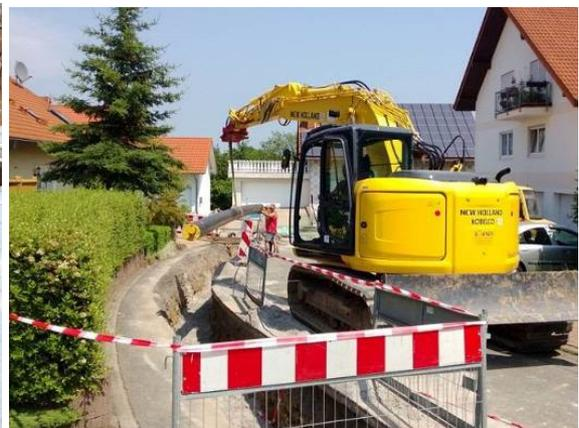
**Abb. 68:** Verlegung KMR-Rohr
