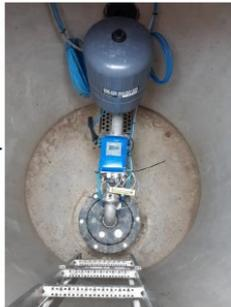
**Abb. 66:** Brunnenbohrung für Grundwasser-Wärmepumpe (Quelle: tevag)
