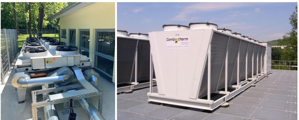
Abb. 65: Tischkühler für Nutzung Außenluft
