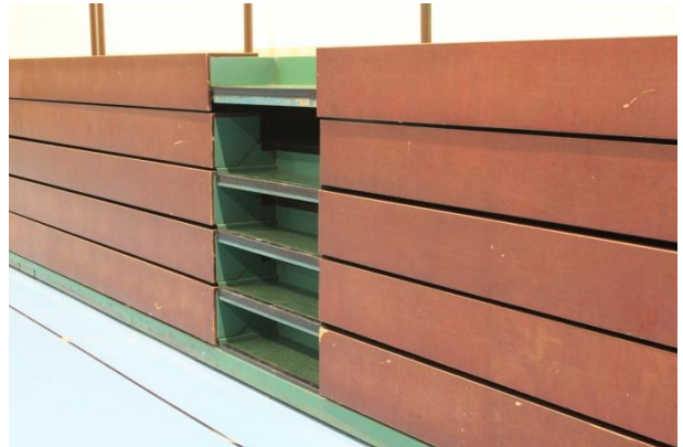
An der Teleskoptribüne fehlen die Abdeckungen der Stufenaufgänge.
