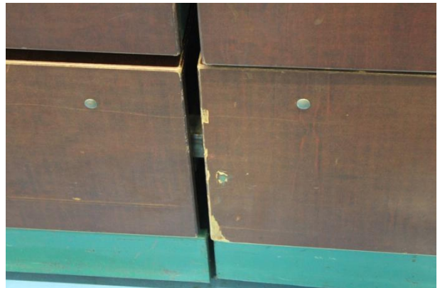
Die Verkleidungen der Tribüne sind z.T. defekt und die Fugen sind deutlich zu breit
