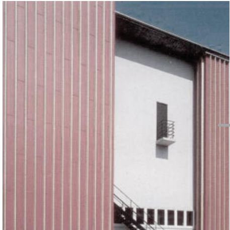
Fassadengestaltung mit vertikaler Struktur (bspw. zementgebundene Flachpressplatten mit Acrylatbeschichtung und Vollholzleisten
