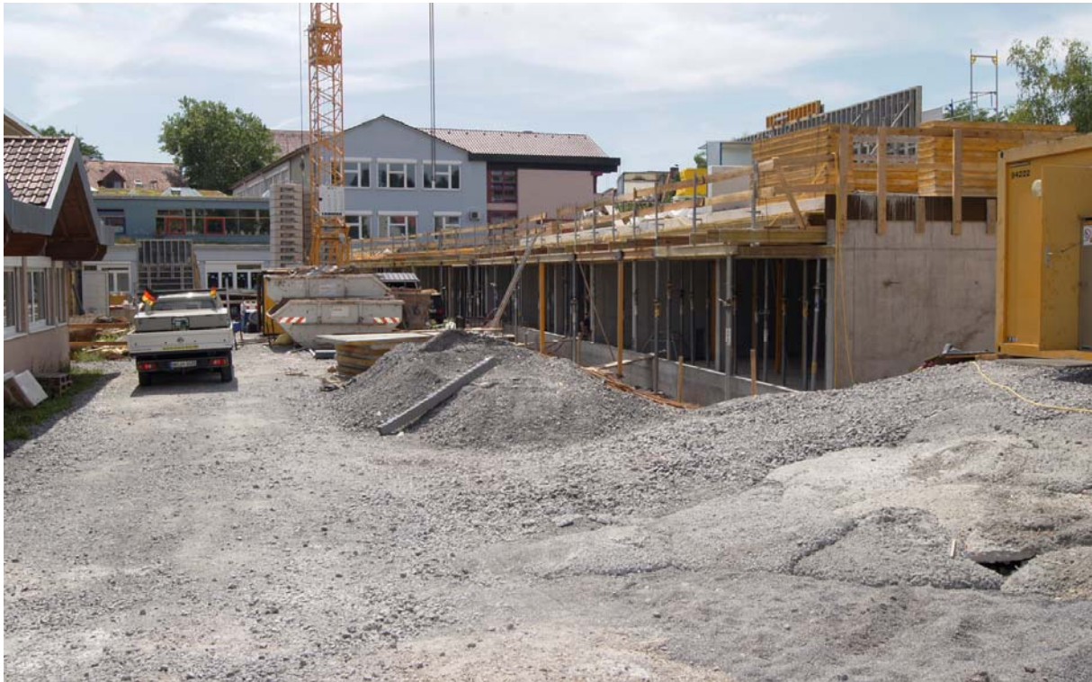
Die Rohbau-Arbeiten am Umbau samt Erweiterung der Realschule machen Fortschritte. Mittlerweile sind 90 Prozent der Aufträge an die entsprechenden Firmen erteilt
