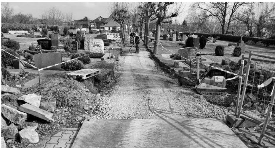
Das Teilstück zwischen der Leonhardtskapelle und der Aussegnungshalle wird nicht nur komplett erneuert, sondern mit einem tragfähigen Unterbau versehen. So ist gesichert, dass der Weg künftigen Belastungen durch das Befahren mit Friedhof-Fahrzeugen (Kleinbagger u. ä.) stand hält. Wenn alles planmäßig verläuft, sollen die Arbeiten noch vor Ostern zum Abschluss kommen.
