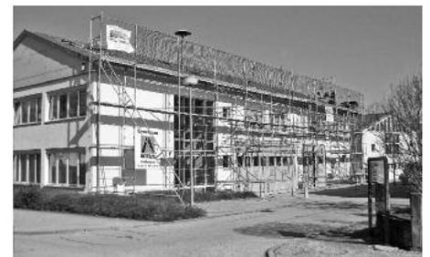
Auf dem Dach des Rathauses/Feuerwehr wird auf einer Fläche von 139 m<sup>2</sup> eine Anlage mit einer Leistung von 20,73 kW errichtet.
