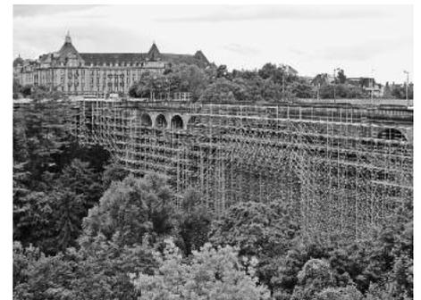
„Leichte“ Einrüstung der luxemburgischen Adolphe-Brücke: Der Gerüstbau zur Sanierung des Wahrzeichens ging dank einer Kombination aus AllroundGerüst und dem neuen Allround Lightweight von Layher schneller voran als geplant.
