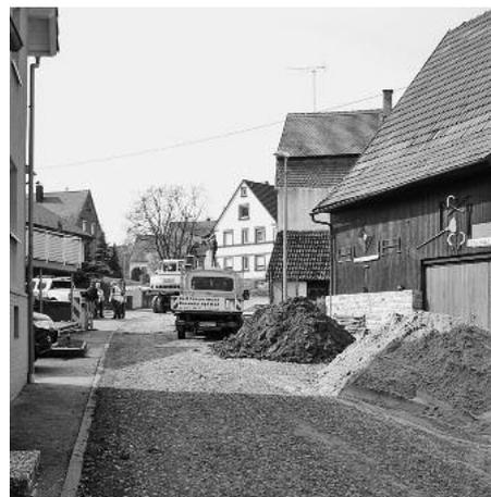
In der Industriestraße werden bis Anfang Mai die Vorarbeiten für die Herstellung des Endbelags ausgeführt und die Straßeneinlaufschächte entsprechend angepasst. Im Weiteren werden die Arbeiten am Gehweg fortgeführt bzw. der neue Pflasterbelag und die Rabatten eingebaut.
