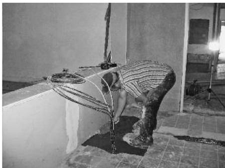
Vom Bauhof wurden die für die Neuinstallationen erforderlichen Leitungsgräben betoniert und für den Fliesenleger vorbereitet. Im Bereich des bisherigen Lichthofs wurde von den Mitarbeitern des Bauhofs ein neuer Estrichbelag eingebaut, um in der kommenden Woche den geplanten Aufzug an dieser Stelle installieren zu können.
