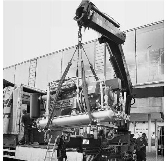
Zunächst wurden die notwendigen Leitungen samt Heizkessel installiert, dann das 1,8 Tonnen schwere Aggregat mit einem LKW-Kran dorthin „gelupft“, wo es künftig seine Dienste verrichten wird.
