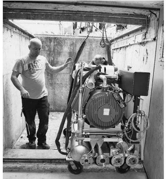
Das neue BHKW wurde über einen speziell angefertigten Schacht in den Keller gefahren und musste dort mit einer mobilen Kran-Brücke über eine Bodenschwelle gehoben werden, ehe es an das neu montierte Heizsystem angeschlossen wurde.
