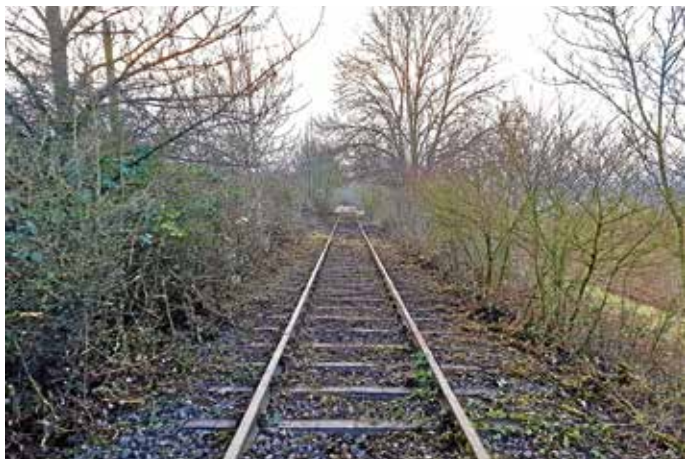
Nach dem Freischnitt, Schiene in Sicht
