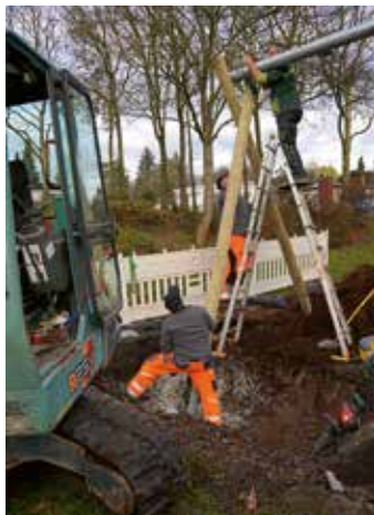
An der Seilbahn musste vom Bauhof ein Träger ausgetauscht werden.
