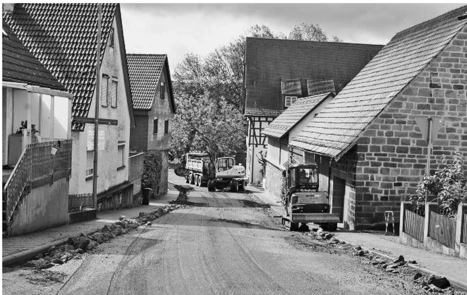
Die Bauarbeiten sollen bis zum 24. Mai abgeschlossen sein. Aktuell sind die Bautrupps dabei, nach dem Abfräsen des Asphaltbelages Randsteine zu erneuern und das Bahngleis aus der Cleebronner Straße zu entfernen.
