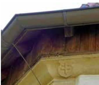
Am Gebäude gibt es ebenfalls Details, die Rätsel aufgeben.
