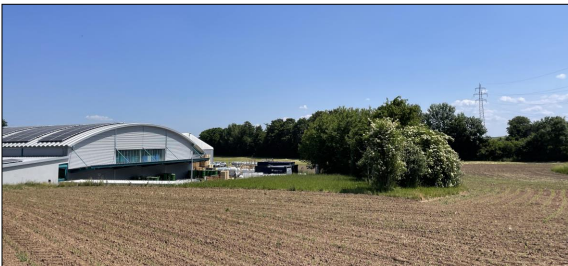
Blick auf Gewerbehalle u. vorgelagerte Grünfläche mit jungen Gehölzen, im HG Gehölze am Flügelaubach
