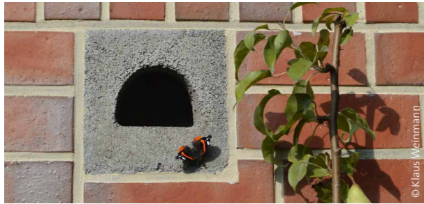
▲ Halbhöhle in Klinkerfassade
