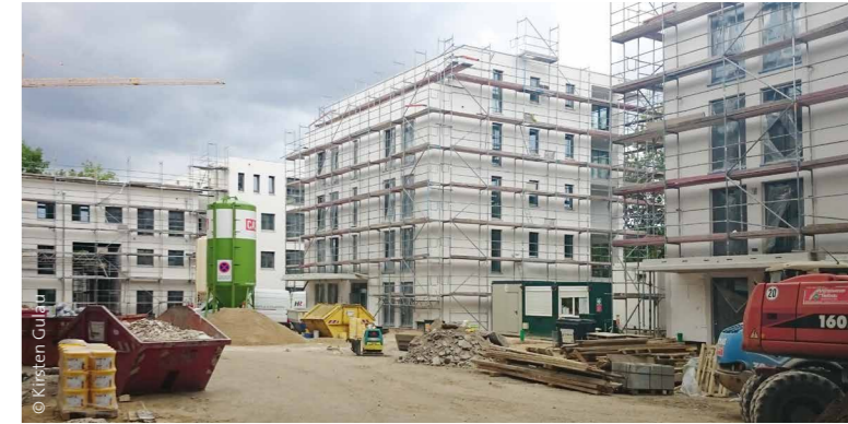
▲ Eingerüstete Gebäude auf Baustelle
