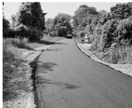
In der vergangenen Woche hat die Firma Reimold aus Gemmingen die Asphalt-Arbeiten ausgeführt. Danach wurden die Bankette links und rechts des Feldweges an den Fahrbahnbelag angeglichen.
