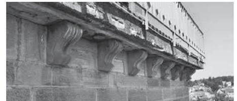
Das Sandsteinmauerwerk wurde untersucht und dokumentiert. Lose Sandsteinteile und lose Betonteile des Turmbalkons wurden aus Sicherheitsgründen gleich entfernt. Es wird eine Sandsteinkartierung erstellt, die dann zusammen mit weiteren Unterlagen dem Denkmalamt vorgelegt werden muss, bevor mit Sanierungsarbeiten begonnen werden kann.
