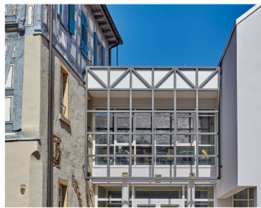
Am Übergang zwischen altem Amtshaus und neuem Rathaus erinnern Stahlstreben an Fachwerk.
