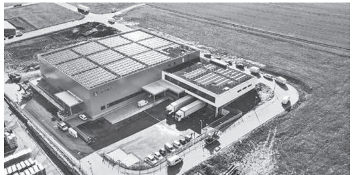
Für umweltfreundliche Energie sorgt die über 2.000 Quadratmeter große Photovoltaikanlage auf dem Dach des Logistikzentrums.
