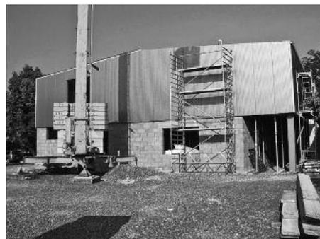
Am Samstag, 26.06., wurde auch noch auf dem letzten Dach der bisher bestehenden Gebäude die Unterkonstruktion für die Sandwichplatten vorbereitet und diese auch gleich verlegt.
