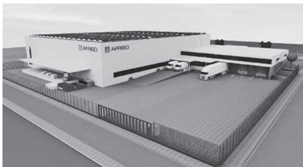
Der 4.750 m 2 große AFRISO Neubau bietet Platz für ca. 3.500 Palettenstellplätze. Zum Jahresanfang 2021 sollen dann die Abteilungen Logistik, Versand und Service das Gebäude beziehen können.
