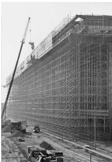
Für die Arbeiten an der Dachkonstruktion wurde die Wandlitzer B+P Gerüstbau GmbH („B+P“) mit dem Auf- und Abbau von Arbeits- und Schutzgerüsten beauftragt. Insgesamt erstellten die Gerüstbauer mit dem flexiblen Allround-System von Layher rund 850.000 Kubikmeter Raumgerüst mit circa 50.000 Quadratmeter Grundfläche – freistehend, da eine Befestigung am Bauwerk nicht möglich war – sowie etwa 8.500 Quadratmeter Hängegerüst.
