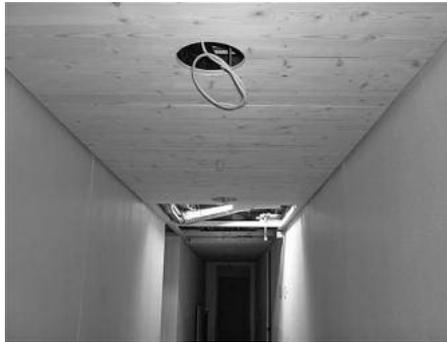
Im Flur der Sporthalle wurde die Metall-Lamellen-Decke entfernt, mit einer Holzverschalung und neuen Beleuchtungskörpern ersetzt. In den Umkleidekabinen werden Bewegungsmelder zur Licht-Steuerung montiert.
