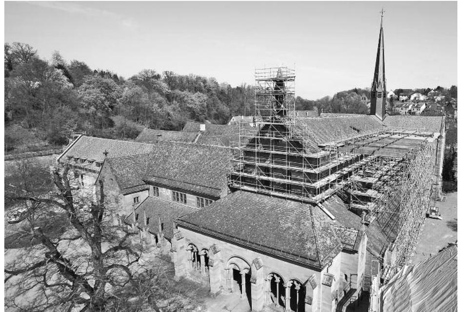
Eine trickreiche Lösung mit dem AllroundGerüst von Layher: Bei der Renovierung des historischen Daches und der Fassaden der Klosterkirche Maulbronn hängte Gerüstbau Burkart das Arbeitsgerüst an Holzleimbändern ab.
