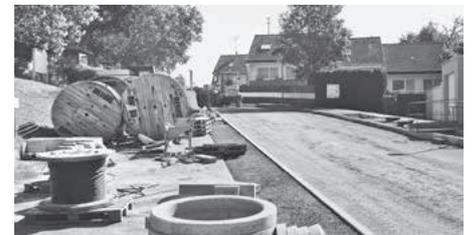
Im Sonnenrain geht es mit den Sanierungsmaßnahmen voran. Im ersten Bauabschnitt sind die Kanalschäden repariert und die Arbeiten an den Wasserleitungen abgeschlossen. Auch eine Tragschicht für den Asphalt wurde inzwischen bis zur Mitte der Ausbaustrecke aufgebracht.
