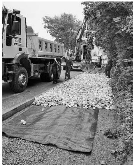
Die Verwendung von Sandsteinschotter wurde ausgeschlossen, da dieses Material aufgrund der starken Schatteneinwirkung mit der Zeit zu stark verwittert. Das verwendete Granitmaterial grenzt sich außerdem sehr gut zum angrenzenden Hang hin ab und bildet somit einen gewissen wahrnehmbaren Kontrast.
