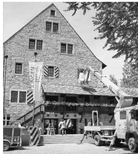
Die Schreinerei Höfle aus Güglingen hatte den Auftrag für die Erneuerung erhalten und die in den Landesfarben lackierten Klappläden mit Hilfe eines Autokrans montiert.
