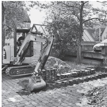
Diese Woche haben die Tiefbaumaßnahmen für den Stromanschluss der Elektroladesäule für Elektrofahrzeuge im Stadtgraben begonnen. Am Parkplatz vor der Tiefgarage wird eine E-Ladesäule der EnBW Typ „AC Ladestation 3.0“ zur Ausführung kommen. Die E-Ladesäule verfügt über zwei Ladepunkte mit Typ 2 Stecker max. 22 kW und Schuko-Stecker bis 3,7 kW. Der Service und Betrieb erfolgt über die EnBW. Die Maßnahme wird vom Bundesministerium für Verkehr und digitale Infrastruktur mit 5.552,00 € gefördert.
