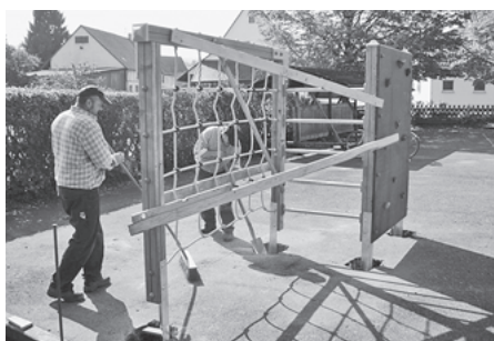
Bauhofmitarbeiter montieren die Kletterkombination
