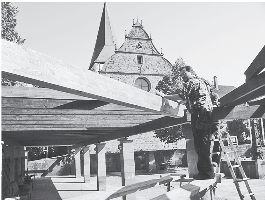
Die Fa. Koch beim Austausch einzelner Trägerbalken der Pergola auf dem Kelterplatz
