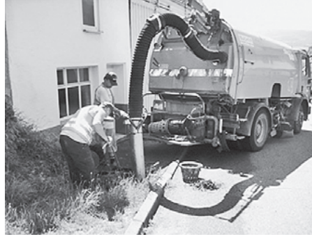
Die Mitarbeiter der Firma Dotterer bei der Reinigung eines Kanalschachtes
