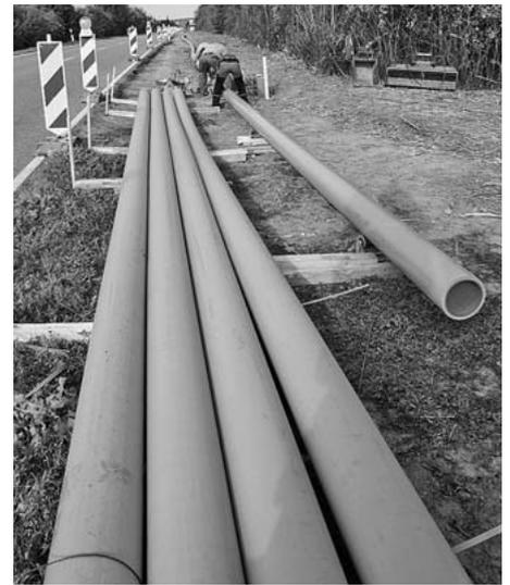
Ein Bautrupp der Firma Leonhard Weiss (Bad Mergentheim) ist im Auftrag der MVV-Energie AG (Mannheim) dabei, die 400 Meter lange Leitung mit einem Durchmesser von 225 Millimeter in Richtung Gewerbegebiet „Burgweg“ in den Boden zu bringen, damit dort das „Werk II“ der Firma Layher mit Erdgas versorgt werden kann.
